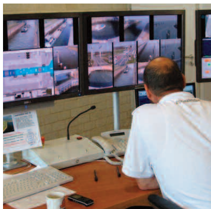
24-uurs besturing en bewaking van bruggen en sluisen
